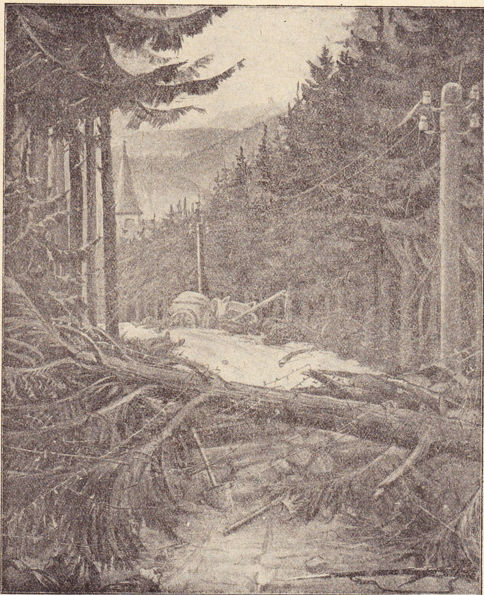
Une barrière construite par les Français dans les Vosges.
